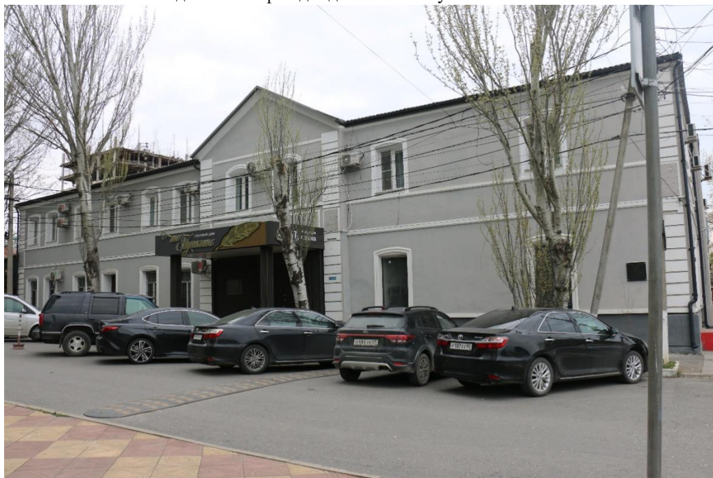
Вид главного фасада здания № 2 по ул. С. Стальского.
