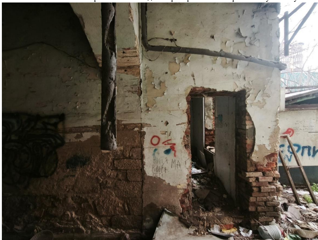
Место примыкания поздней пристройки к историческому объему
