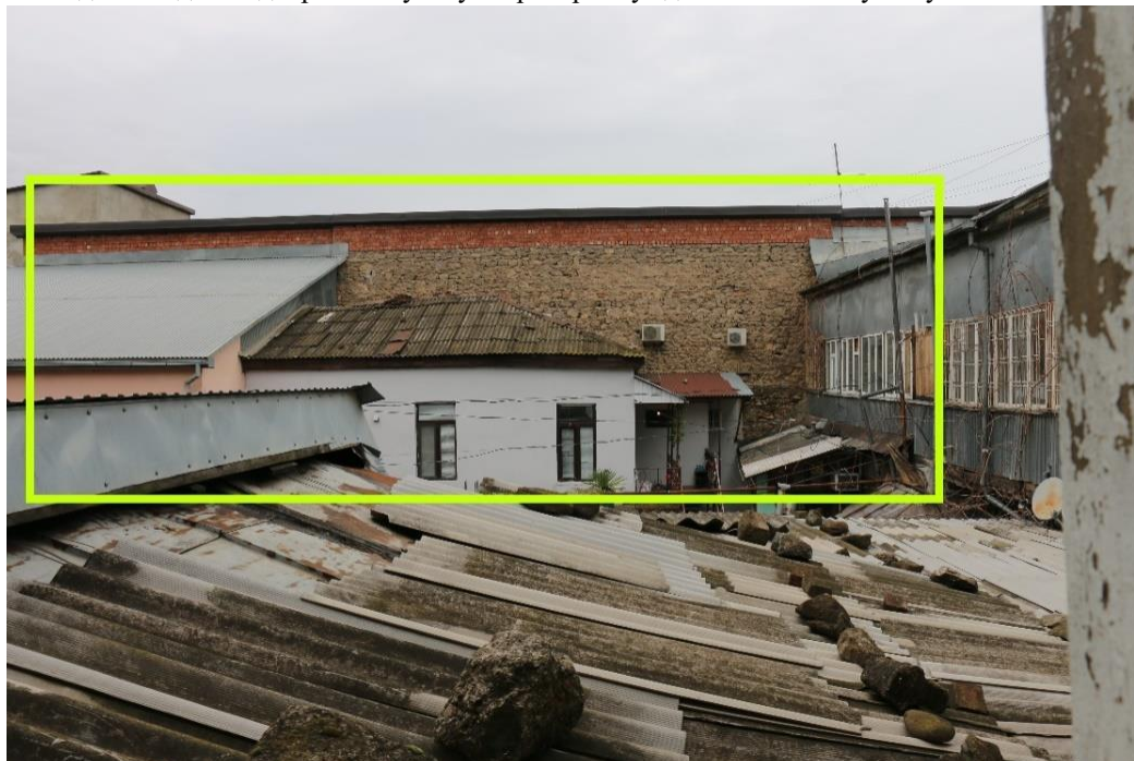
Вид на позднюю дворовую бытовую пристройку здания № 4/1 по ул. Пушкина
