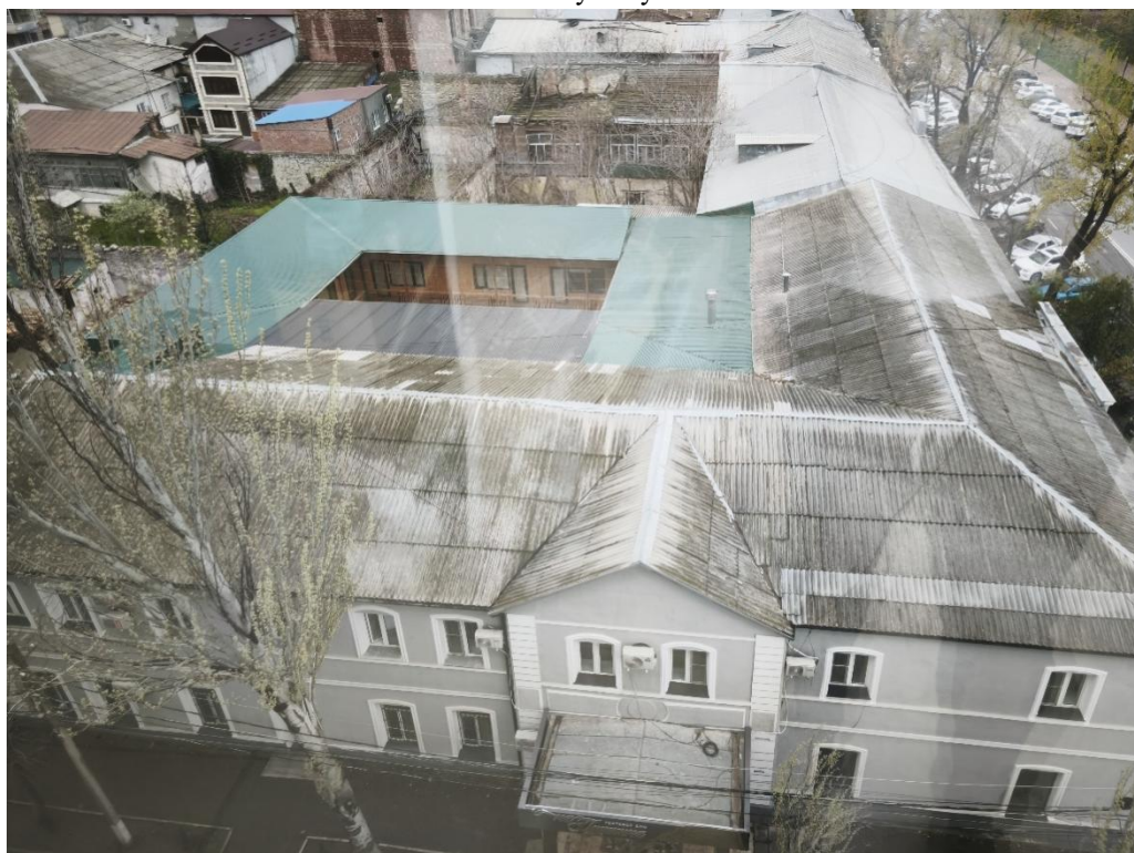
Современная дворовая пристройка, примыкающая к фасадам здания № 2 по ул. С. Стальского и № 10 по ул. Пушкина.
